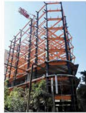
هتل ویستریا تهران مساحت اجرا: ۱۲۰۰۰ مترمربع
